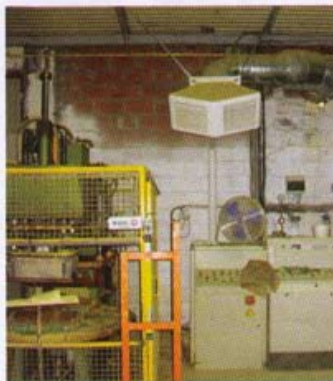
► La diffusion d'air est réalisée par un plénum à deux directions / The air distribution is made by a two-way plenum (doc. AER).
